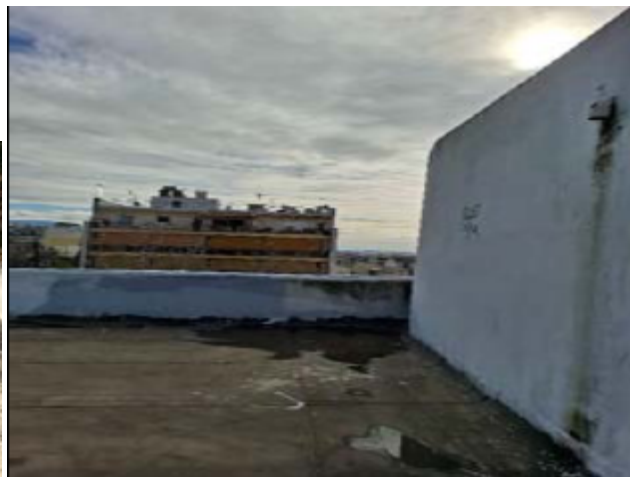
Εικόνα: Λιμνάζοντα ύδατα και έλλειψη κατάλληλων μονώσεων στις πλάκες οροφής των δωματίων δημιουργούν υγρασία
