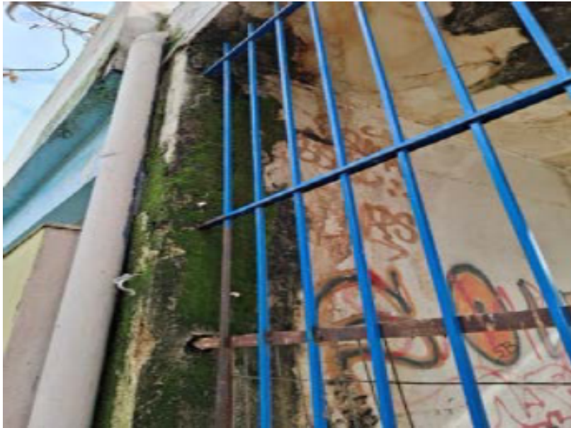
Εικόνα: Παρουσία υγρασίας και βλάστησης σε στοιχεία σκυροδέματος
