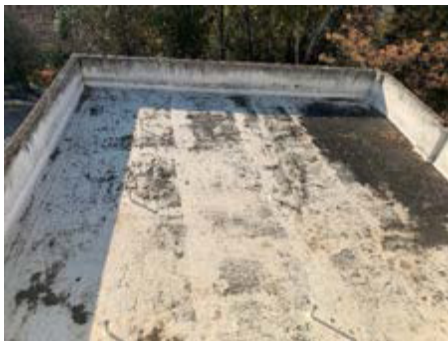
Εικόνα: Λιμνάζοντα ύδατα και έλλειψη κατάλληλων μονώσεων στις πλάκες οροφής των δωματίων δημιουργούν υγρασία
