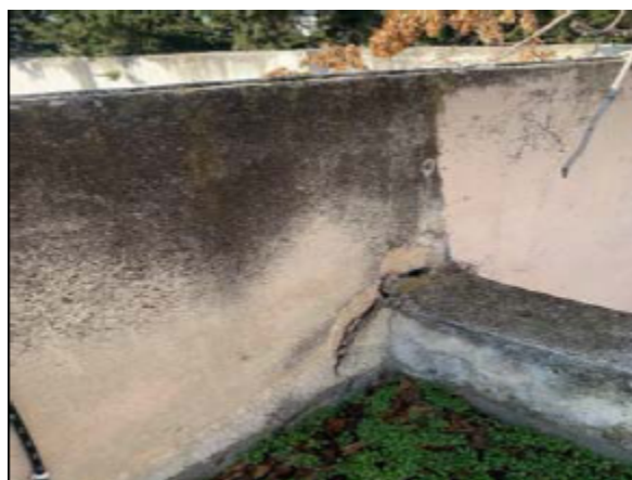
Εικόνα: Ρηγματώσεις στο σοβά στο εξωτερικό των κτιρίων
