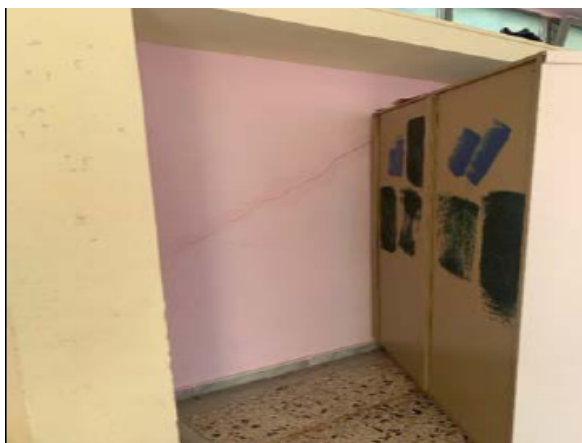
Εικόνα: Οι ρωγμές στις τοιχοποιίες στο Κτίριο III στο εσωτερικό του
